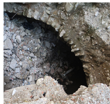
露呈したローマ時代の暗渠
